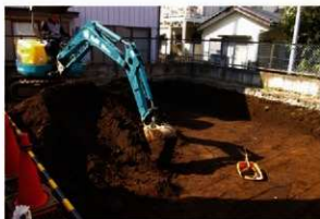
2. 表土剥ぎ風景
