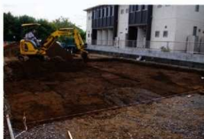
3. 表土剥ぎ風景
