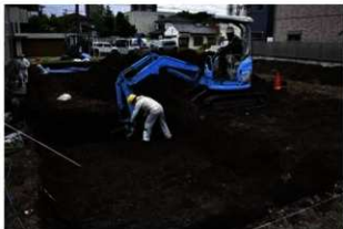
西区 重機掘削状況(北西から)
