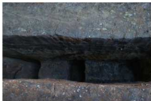
堰断面下位北側（西から）
