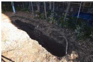
写真VI-1 61トレンチ断面 南西から
