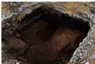
写真V-17 22D区 完掘状況 南西から
