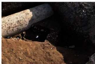
写真V-9 22B区 SD01 遺物出土状況 北西から
