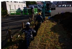
写真IV-7 表土除去作業
