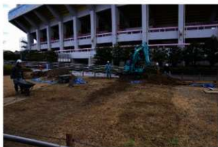
写真Ⅳ-47 埋め戻し作業
