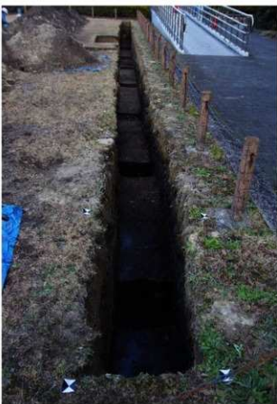
写真IV-34 南北トレンチ全景
