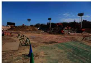
写真II-2 解体が進むスタジアム
