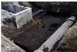
写真V-16 22C区完掘状況 北西から
