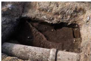
写真V-13 22B区完掘状況 北東から
