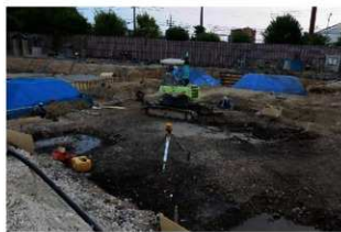
写真Ⅶ-1 シンダー層上面のフーチング床掘状況
