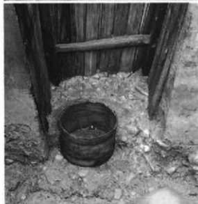
SE01 水溜 (南西から)
