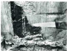
剥離箇所に膠水含浸
