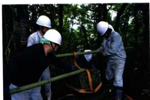
1号石塔撤去作業
