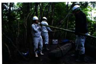
4号石塔撤去作業
