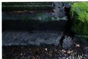
1号石塔南面基礎針金確認状況
