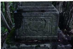
1号石塔南面基礎格状間・反花
