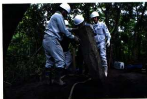
4号石塔撤去作業
