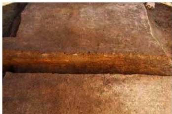
SC01 断面（南から）
