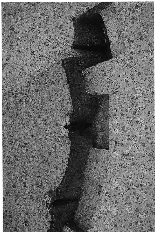
写真101 VSM-01掘出状況2 (裏から)
