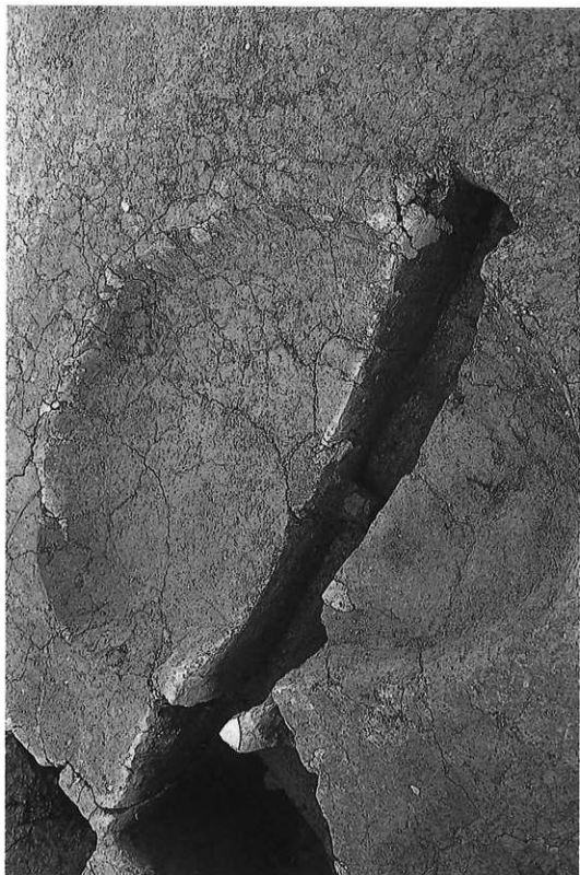
写真15 Ⅲ-15K-11完面状況（雨から）
