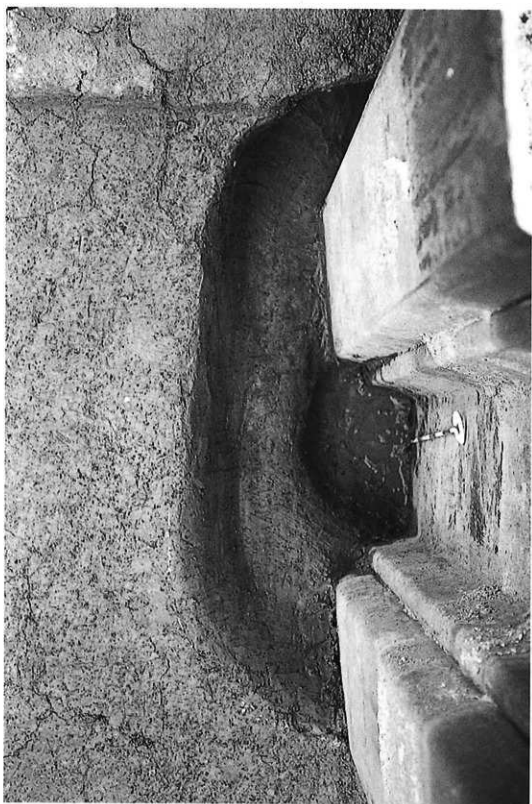
写真68 Ⅲ-2SK-09完備状況（南西から）
