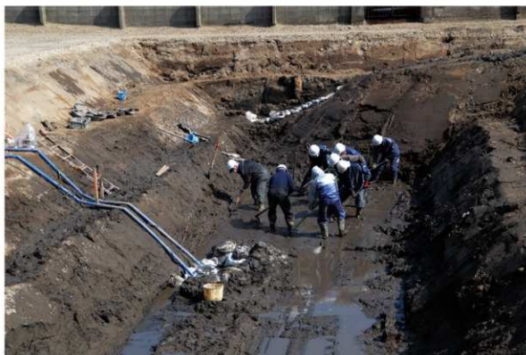
作業風景（西から）
