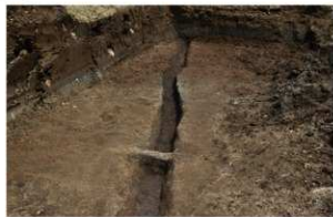
SD-3 北側掘削状況
