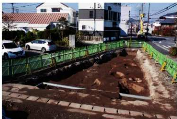
1次区域1全景(東方向から)
