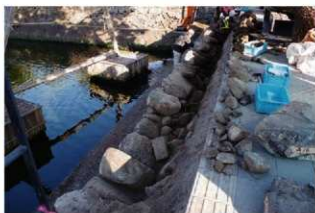
1段目裏込め発掘状況
