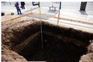
クロマツ移植先掘削状況
