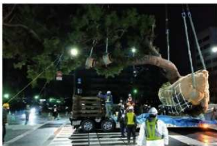
クロマツ移植作業
