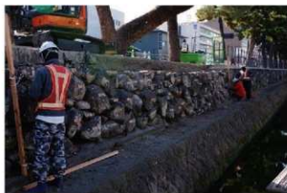
解体石垣の番号付け・丁張設置
