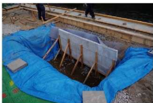
クロマツ若木の移植に伴う養生設置
