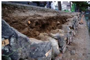
築石2段目解体状況（東から）
