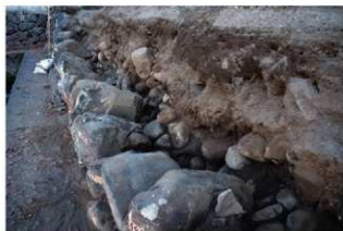
築石2段目解体状況（西から）
