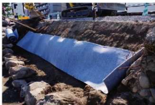
吸出し防止マット設置
