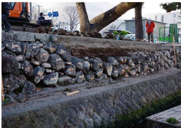
築石1段目解体状況
