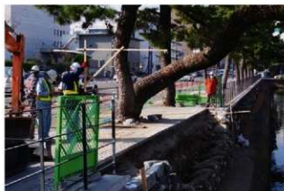
石垣解体面の写真測量
