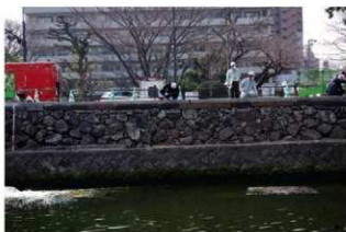
石垣復元完成
