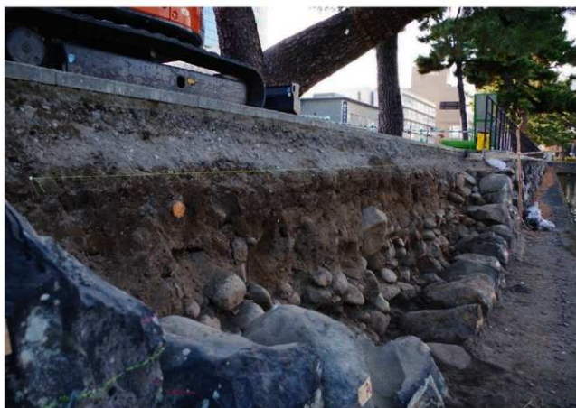
築石3段目解体状況及び土層断面（東から）
