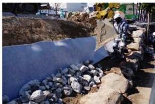
渠石充填作業
