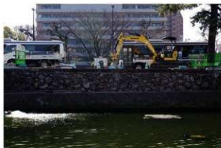
石垣復元状況
