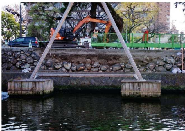
築石2段目解体状況
