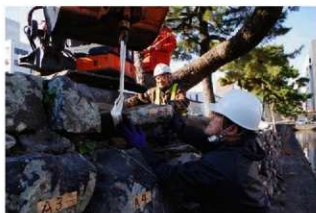
石垣解体作業
