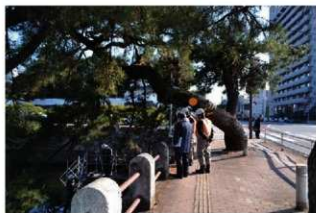
クロマツ移植前（平成29年度・歩道改良前）
