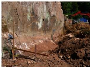
1区側満部掘削状況
