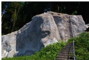
1区施工後現況
