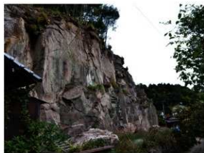
3区壁面 (西から)
