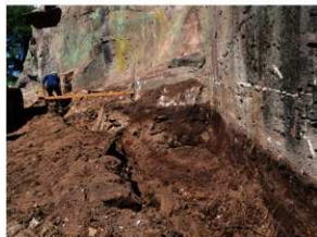
3区側溝部掘削状況
