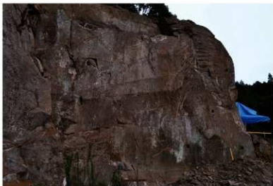
1区壁面（南西から）
