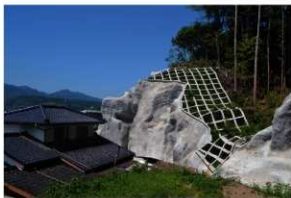
1～2区施工後現況
