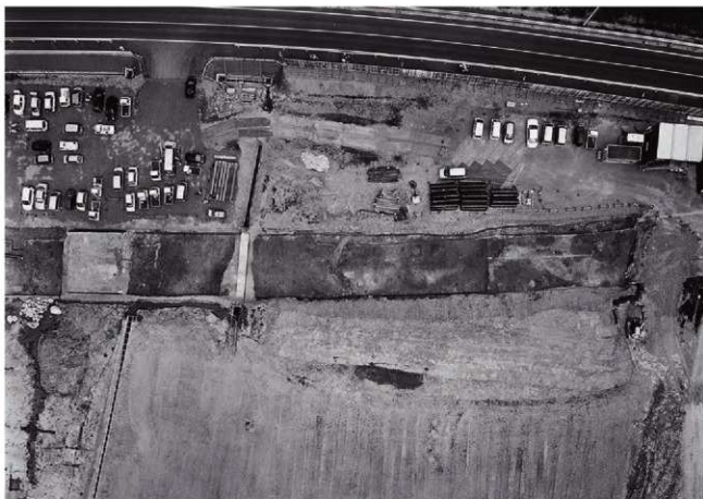
(1) 7区全景 (上空より 左が北)
