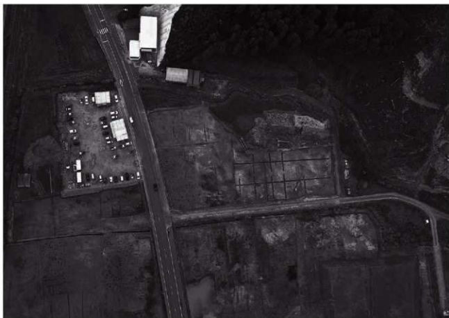
(1) 3区全景 (北方上空より)
