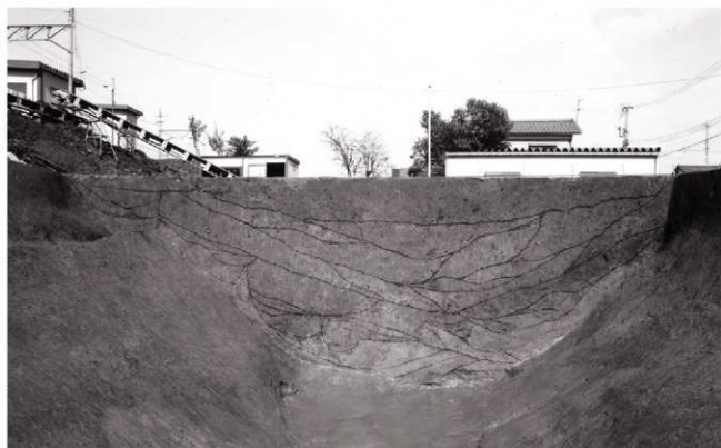
(2) 堀3断面 (南より)
