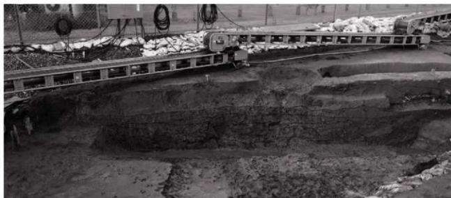
(2) 堀6・7・8断面 (南より)
