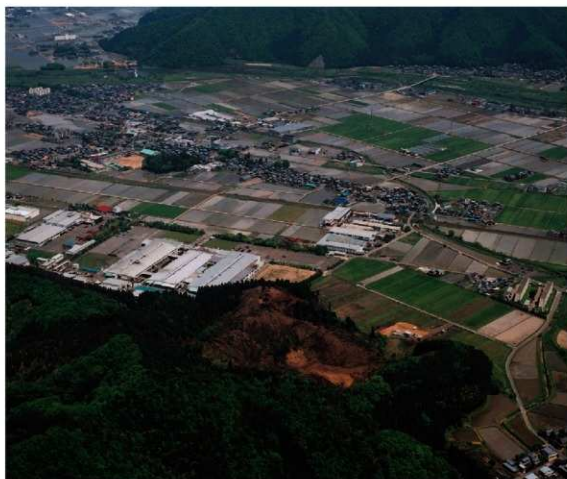
(2) 大塩向山遺跡・山腰遺跡全景（南西上空から）
