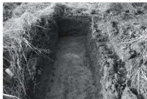
写真 22 20-18 次 トレンチ全景
