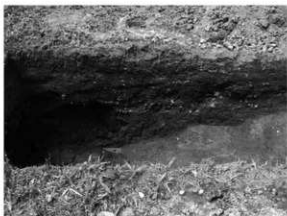
写真 15 1 トレンチ堀上層掘削
