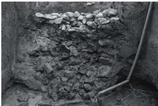
石組井戸SE15断ち割り
