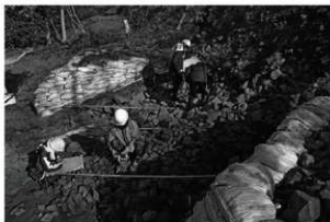
写真4 上段部 崩落石垣実測作業
