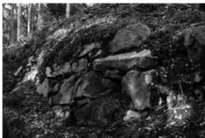
写真 14 曲輪Ⅻ 南側斜面に残る石垣
