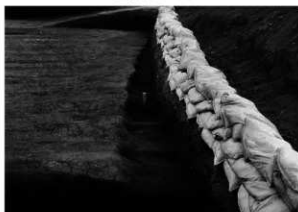
SD05 完掘状況 北から
