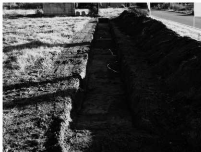
43 R 3 - No603 FP 泥流下遺跡群 (東から)
