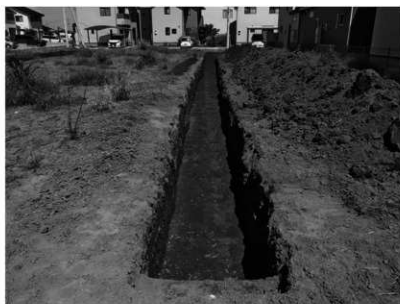
20 R 3 - No252 FP 泥流下遺跡群 (西から)
