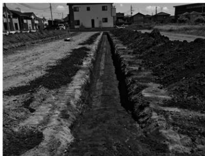
21 R 3 - No359 FP 泥流下遺跡群 (西から)
