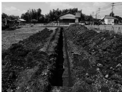
26 R 2 - No.379 FP 泥流下遺跡群 (東から)
