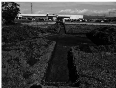
45 R 2 -No.355 宿裏遺跡（南から）
