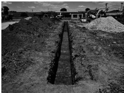
36 H29-№96 道原遺跡（南東から）
