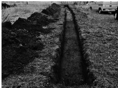
26 H29- No262 世良田環濠集落 (西から)
