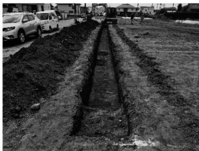
38 H29- No537 東部地区遺跡群（北から）
