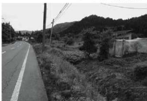
29 山形南陽線板宮工区(南から)
