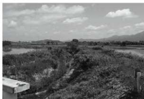
43 最上川上流大規模関連災害事業 (押切築堤) (南西から)
