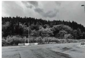
48 一般国道 47 号高屋防災道路(北東から)
