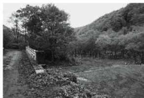
63 穴淵砂防堰堤 (東から)
