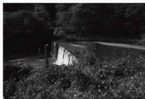
61 橋ノ沢第1砂防堰堤 (北東から)
