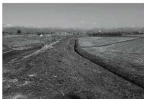
34 古佐川河川整備補助事業(防災安全)築堤工(西から)
