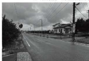
21 荒谷工区 (東から)
