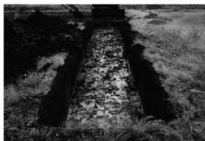
T 5 全景 (南から)
