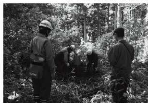
69 金山城跡 工事立会 (北東から)
