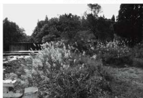
62 小川沢砂防堰堤 (北から)
