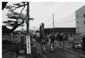
20 鶴ヶ岡城跡 工事立会 (南から)
