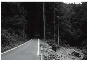
30 一般国道345号(平沢)道路改良工事(西から)
