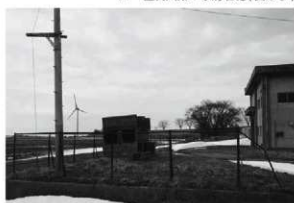
65 国営かんがい排水事業二段割排水機場(南から)
