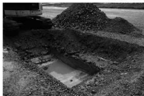
T1 全景（北東から）
