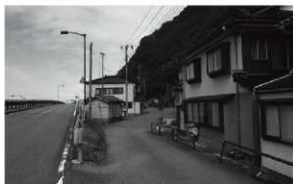
31 一般国道112号(金沢陸橋) 橋梁撤去・道路改良工事(南西から)
