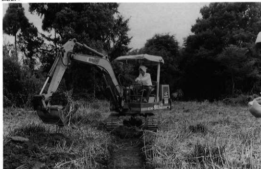
6 トレンチ排土作業
