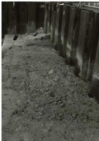
(1) 砂利敷道路2 (北から)
