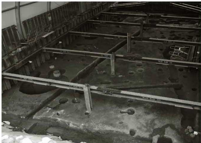
(2) 砂利敷道路3 (南から)
