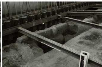
(5) 土坑5-88 (南東から)
