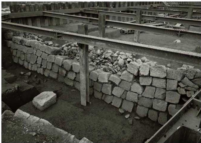
(1) 石垣 2-45 (南東から)
