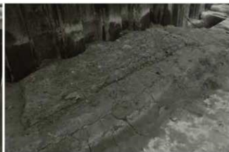
(2) 砂利敷道路2 (南東から)
