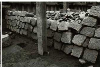
(3) 石垣 2-45 (南東から)
