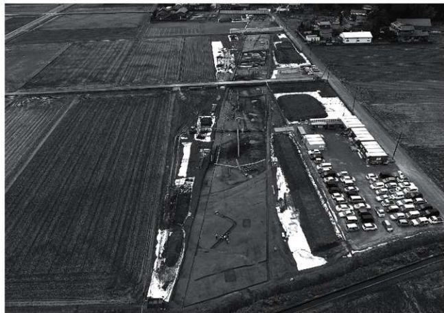
(2) 調査区近景 (北から)
