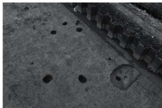
(5) SB5 (北西から)
