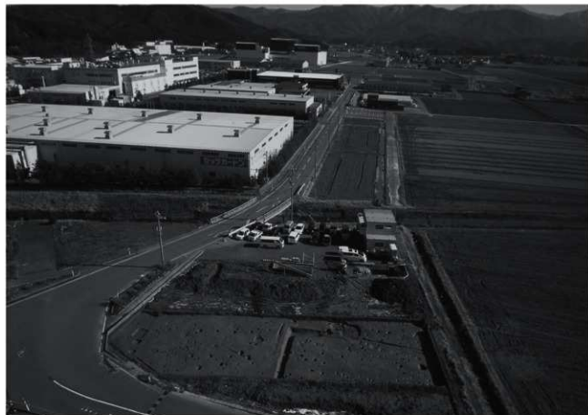
(1) I区(平成27年度調査区)近景 (西から)
