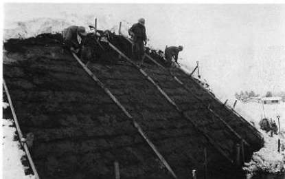
2 盛土・てん圧 作業
