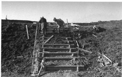
2 くびれ部東側 階段工事作業 状況
