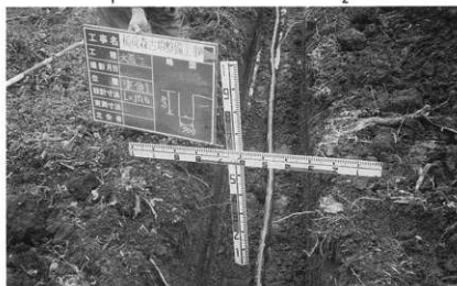
3 給水工事状況
