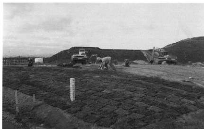
1 張芝工事作業 状況 (平成2年度)
