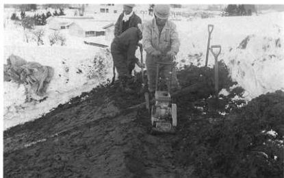
2 盛土・てん圧作業
