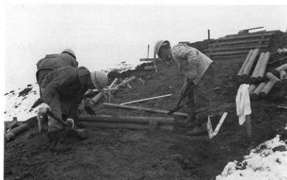
1 後円部階段工事 作業状況
