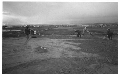
2 盛土・てん庄 作業 (南東から)
