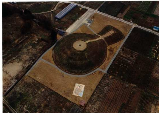
1 整備完了時全景 (平成4年度、北から)
