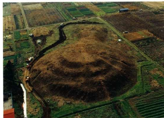
2 着工時全景 (平成元年度、北東から)
