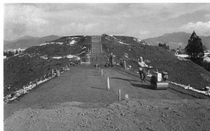
2 前方部頂盛土で ん圧作業
