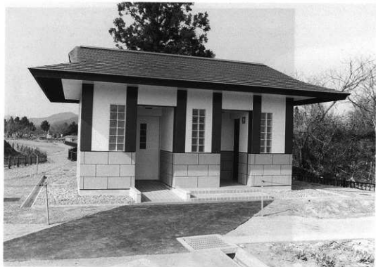
1 便所全景 (南から)
