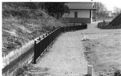
3 防護柵 (転落防止柵)
