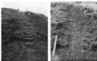
1 後円部東側 石段撤去前状況
