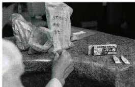
21 各部接合箇所の隙間に補填剤注入
