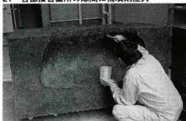
22 接合箇所の着色・剥取面をSK-50で仕上げ
