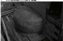
8 (A) 外側をNR-51で密着させ、FRPで固定
