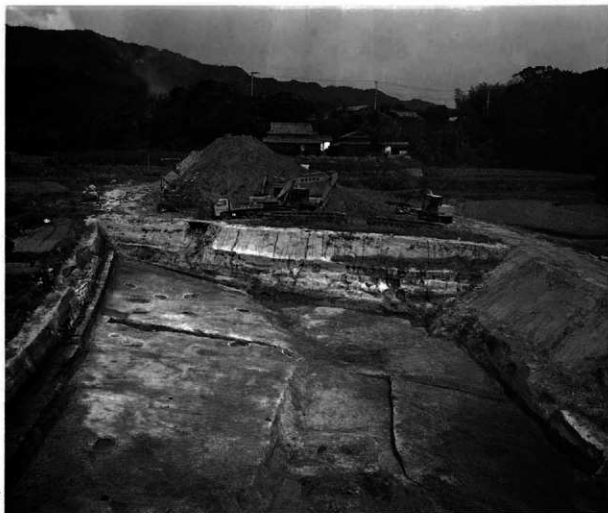
1. 遺構全景 南から
