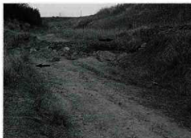
写真1 野島断層の活動による道路の変位(平林地区)
