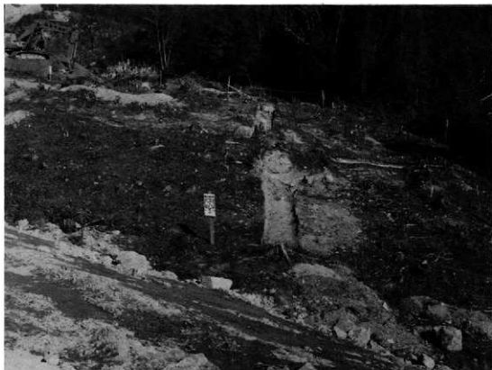
1. 調査前 (南から)
