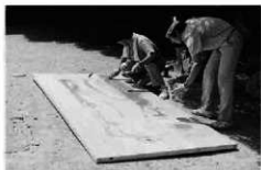
図202 パネルに接着剤を塗る
