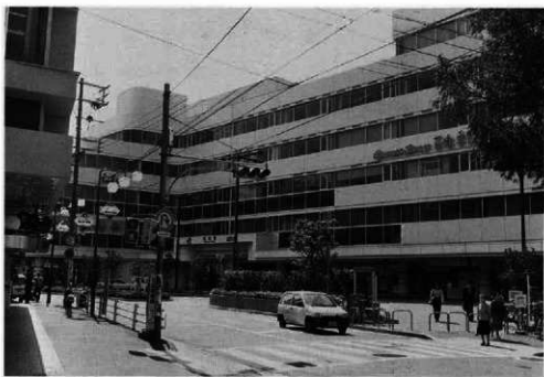
図210 完成した住吉駅ビル
