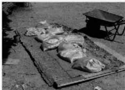
図203 パネルに接着させる
