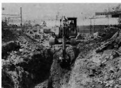
図11 確認調査風景
