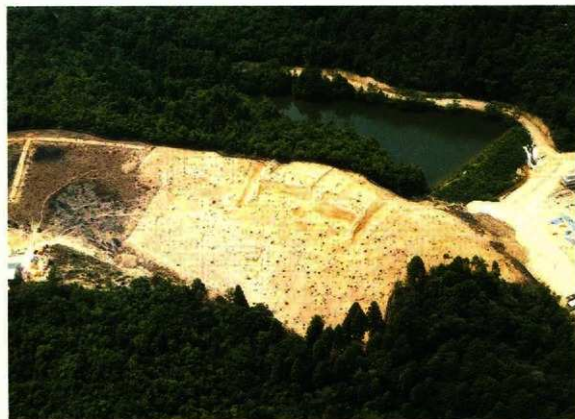
調査後の全景
