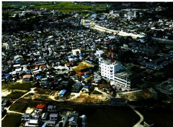
1. 対中遺跡遠景 空中写真(南から)
