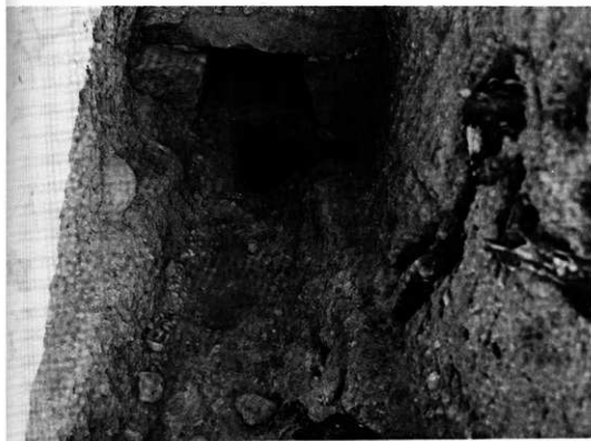
本丸排水施設入口(西から)
