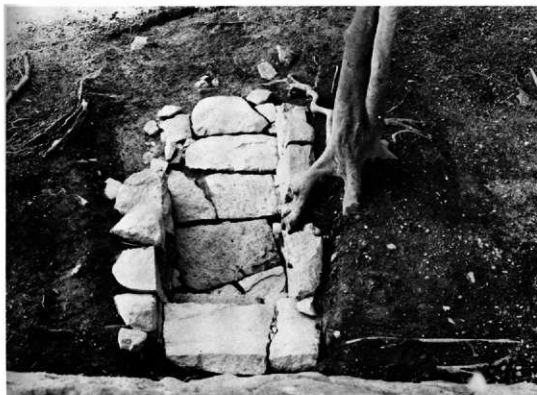
稲荷郭下排水施設（南から）
