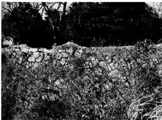
箱福の土塀(北東から)
