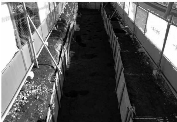
2. L 55 - 1 区第 2 面大全景 (縄文時代確認面) (北西)
