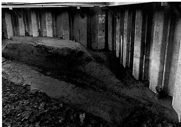
同 堆積土除去後
