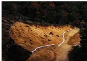
V-2地区 (北西から)
