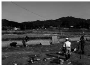
写真2 国土座標杭設置風景
