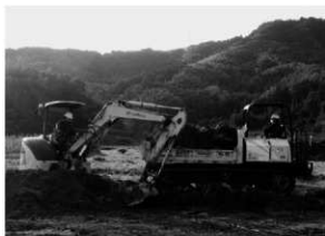
写真1 重機による表土除去
