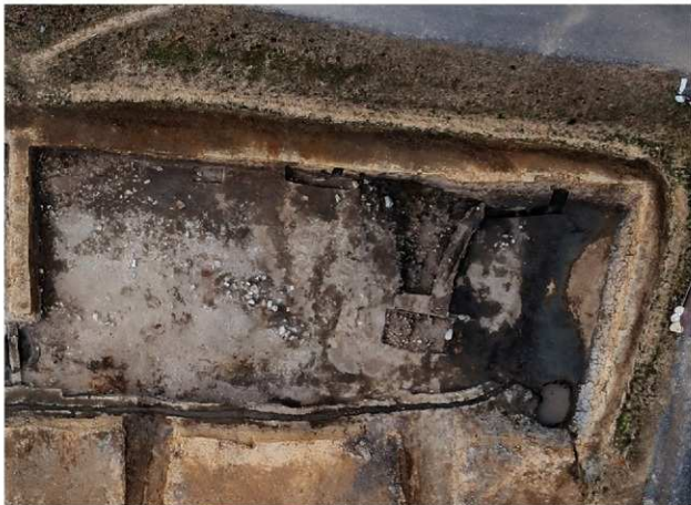
1 北トレ以北 完掘状況（真上から 上が西）
