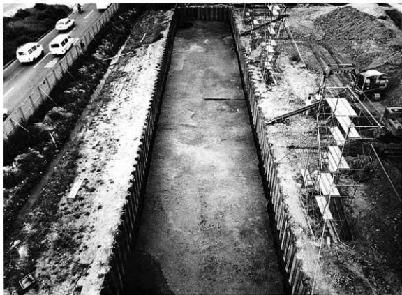
Cトレンチ 全景 (南から)
