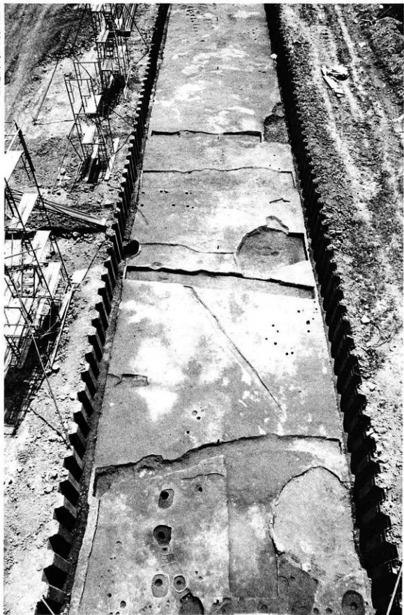
Cトレンチ 全景 (北から)
