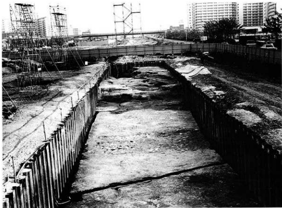
Bトレンチ河川Ⅰ・Ⅱ（北から）
