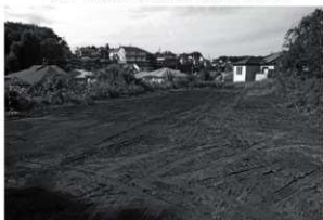
調査終了状況（南東から）
