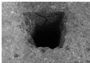
4. S103-P4 Bセクション 西から
