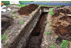
4:Cトレンチ 完掘状況
