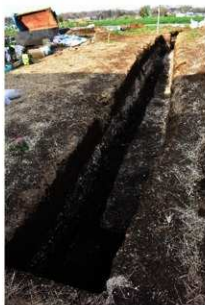
1:Aトレンチ 完掘状況
